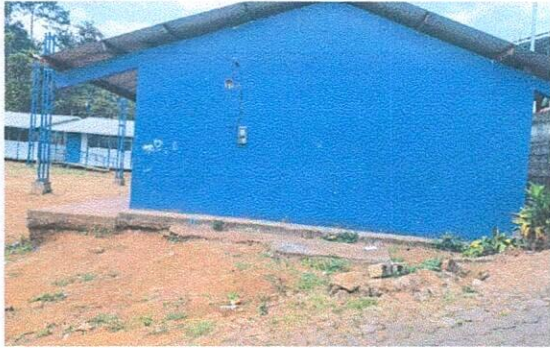
Foto 1: Reparación de plancha de concreto del patio lateral
