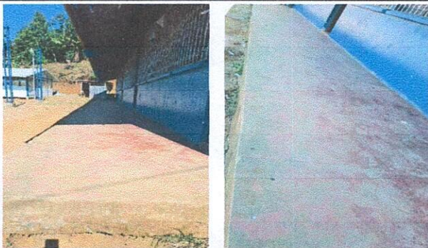
Foto 5: Sustitución de piso de granito en el corredor
