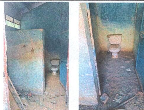
Foto 4: Reparación de servicio sanitario
