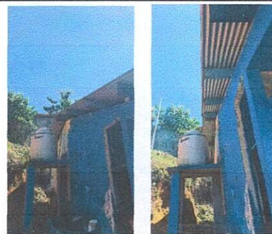
Foto 6: Sustitución de lamina por lamina troquelada
