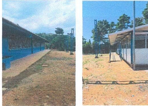
Foto 2: Reparación de plancha de concreto del patio frontal
