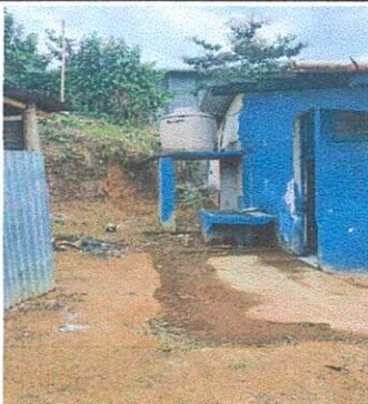
Foto 3: Reparación de galeras con laminas troqueladas
